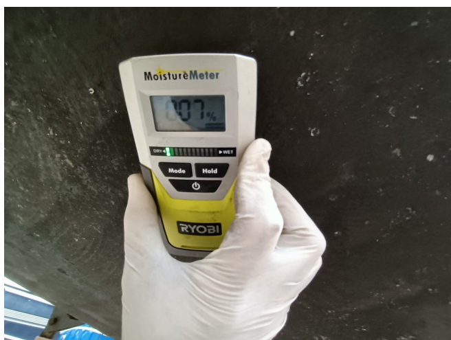
Figura 2: misurazione umidità carena
